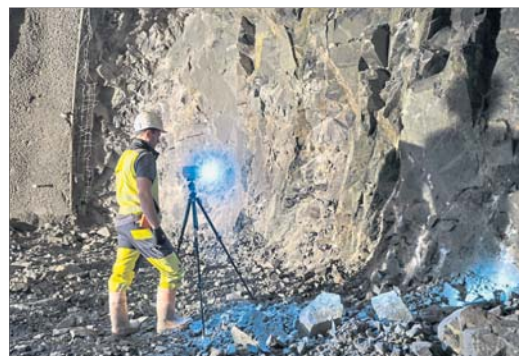
3-D-Vermessung aus Kamerabildern wird auch im Tunnelbau eingesetzt. [Droit Messstechnik GmbH]
